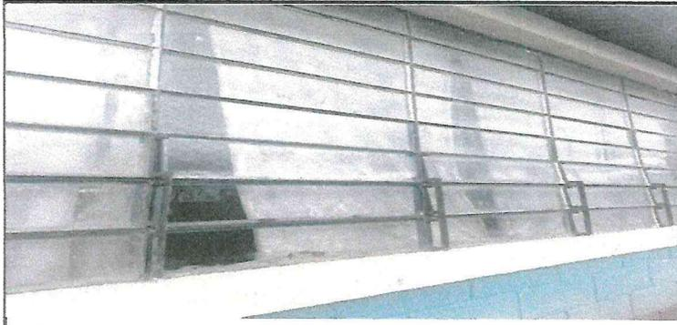
Foto1: sustituidos todos los vidrios quebrados
