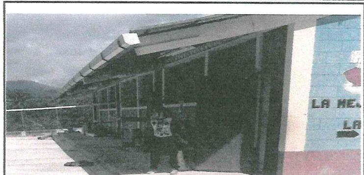
Foto 2: Canal de metal totalmente colocado
